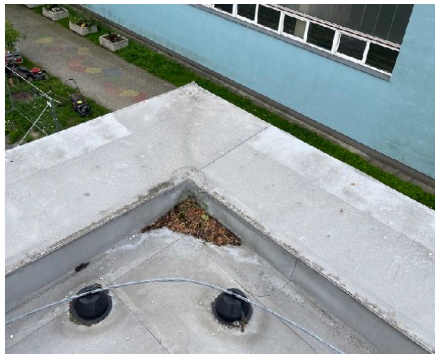
Obrázek 2 - Atiková konstrukce střechy
