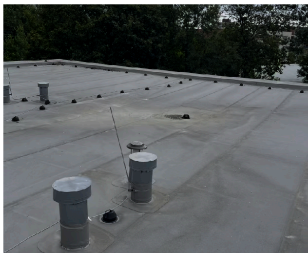
Obrázek 6 - Větrací komínky a vpust'
